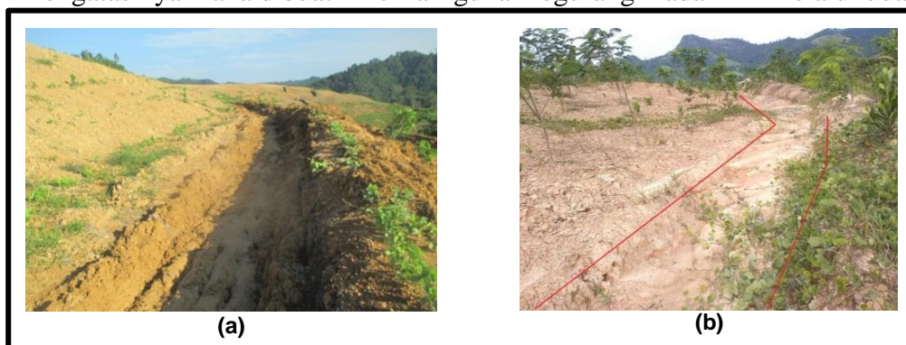
Gambar 2. Foto Kondisi Parit Awal (a) dan Kondisi Parit Akhir (b)
