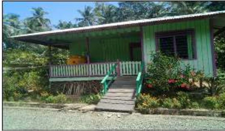
Gambar 1. Kondisi Bangunan Rumah Kayu Desa Tanjung Nanga
