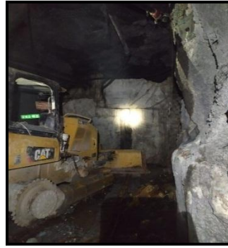
Gambar 5 Kondisi Pintu Angin
